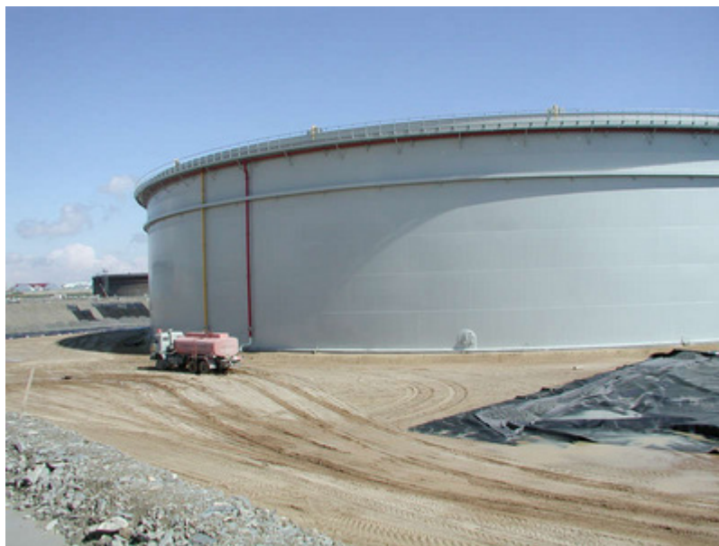
Рис. 1. Резервуар вместимостью 100 000 м 3 Каспийского трубопроводного консорциума «КТК-Р», г. Новороссийск
